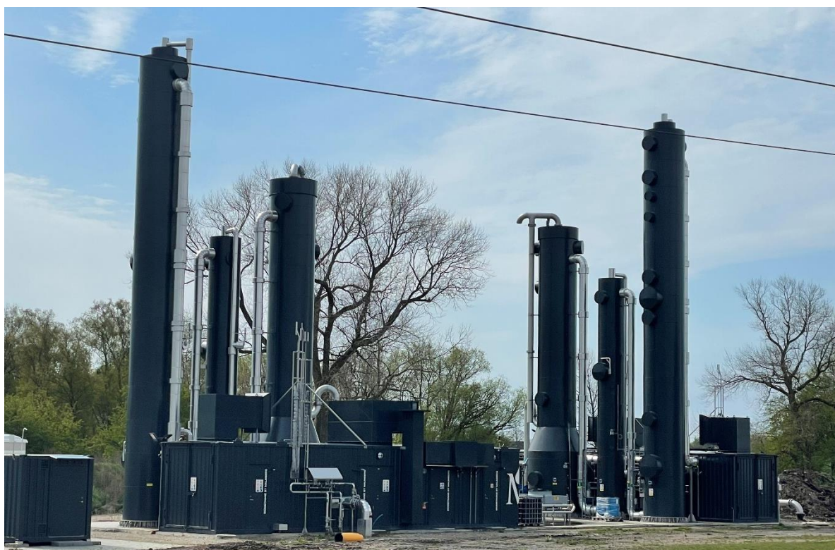
Figur 4. To ens gasopgraderingsanlæg
