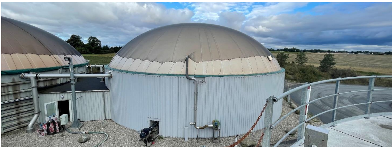
Figur 2. Lagertanke 1 og 2 til afgasset biomasse og gaslager
