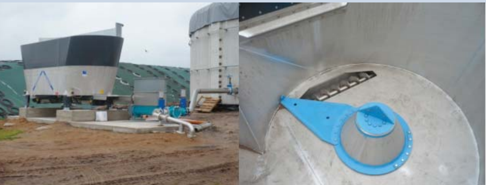
Figur 9. Biomixer til indfødning til biogasanlæg. Til højre vises biomixerens indfødnings- og snitteaggregat
