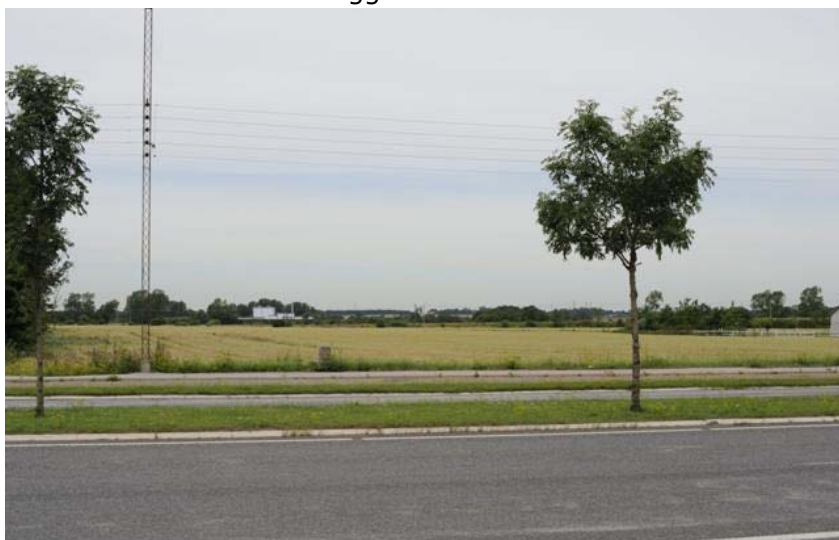
Biogasanlægget set fra Københavnsvej
